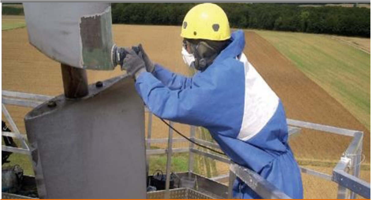
Reparación de palas en campo utilizando plataformas de trabajo
